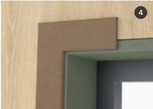
Raamafwerking met MDF en raamlijst.
