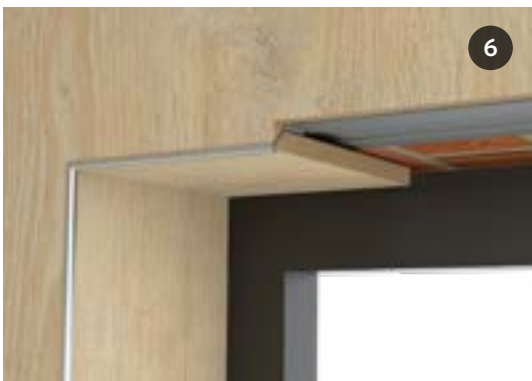
Deurafwerking met aluminium Unilin-profiel.
